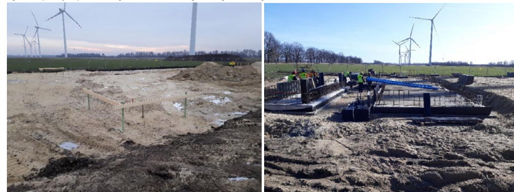
Rys. 1 Rozpoczęcie prac ziemnych i fundamentowych w styczniu i lutym 2019 r.
