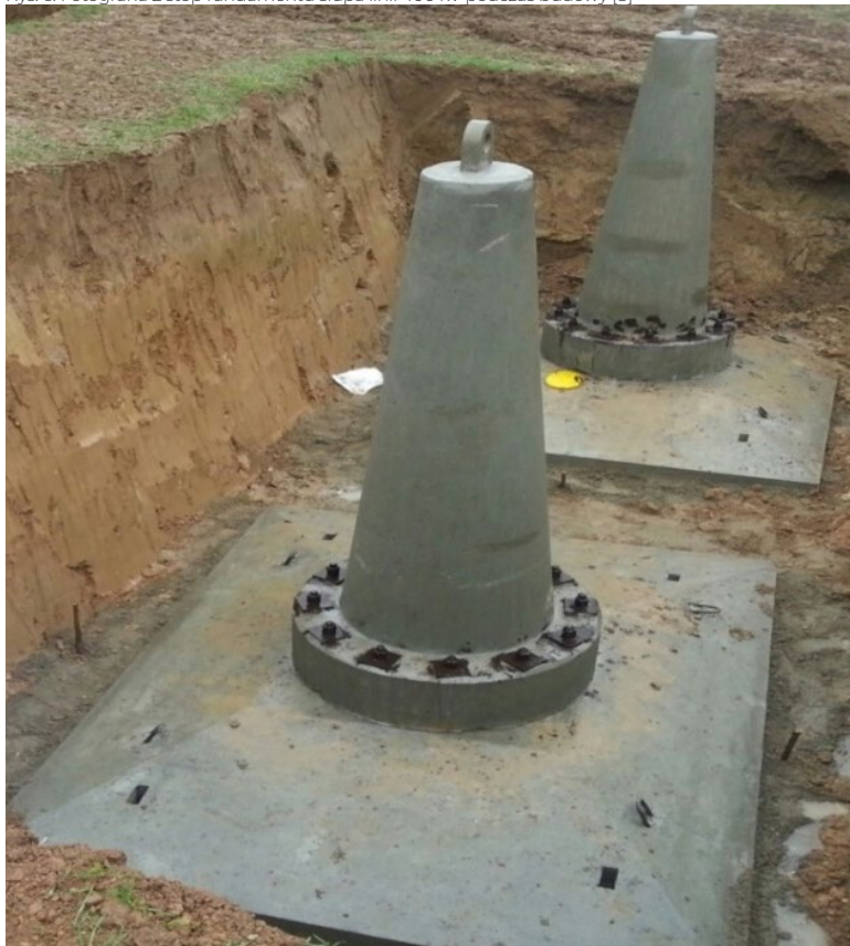
Rys. 6. Fotografia 2 stóp fundamentu słupa linii 400 kV podczas budowy [8]
