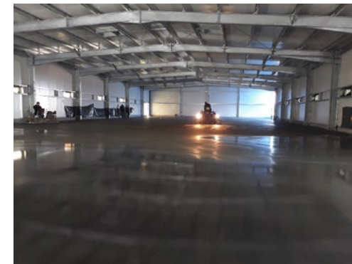
Rys. 3. Wylewanie posadzki pod baterie akumulatorów w hali magazynu
